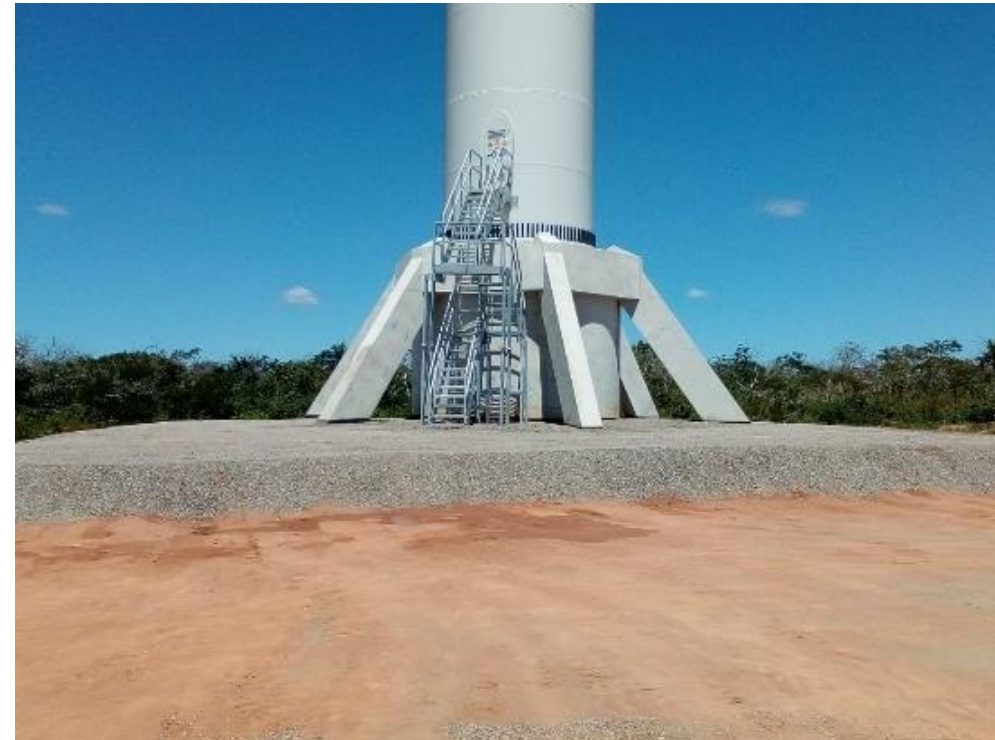
Ventos de Serra do Mel windfarm (Brazil)
