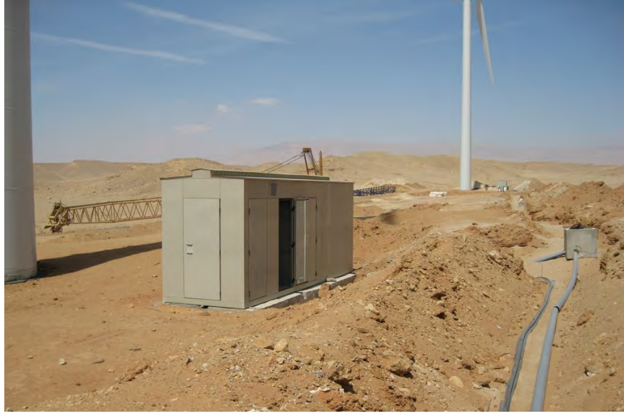
الشكل 1-4: نموذج للأكشاك والأسلاك والتوصيلات الموجودة بجانب كل توربينة رياح.
